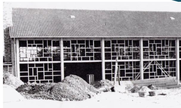
Bau der Turnhalle 1964 / 1965
