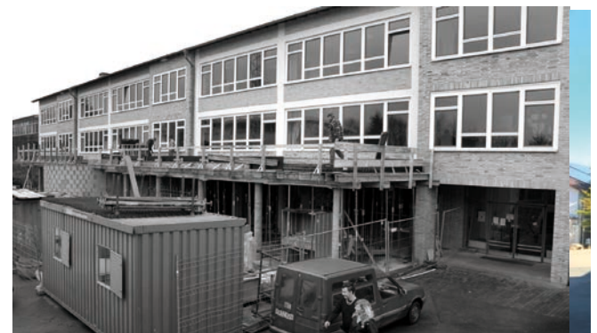
Baumaßnahmen Cafeteria / Bibliothek / Mai 2008
